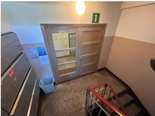
Skats uz kāpņu telpu ēkas 1.stāvā.
